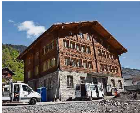
Das Gemeinde- und Vereinshaus wird derzeit saniert.
