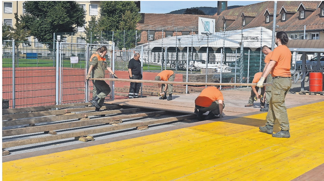
Die Zivilschutzorganisation Wartburg verlegt die Böden, auf denen später grosse Zelte stehen. Bild: lh
